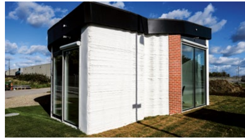
Abbildung 8: a) Produktionsprozess eines additiv gefertigten Gebäude eines Anbieter für Hausbau auf Nachfrage („Building on Demand“), b) Haus, dessen Fundament und Wände additiv gefertigt wurden (Bildquelle:COMOD).
