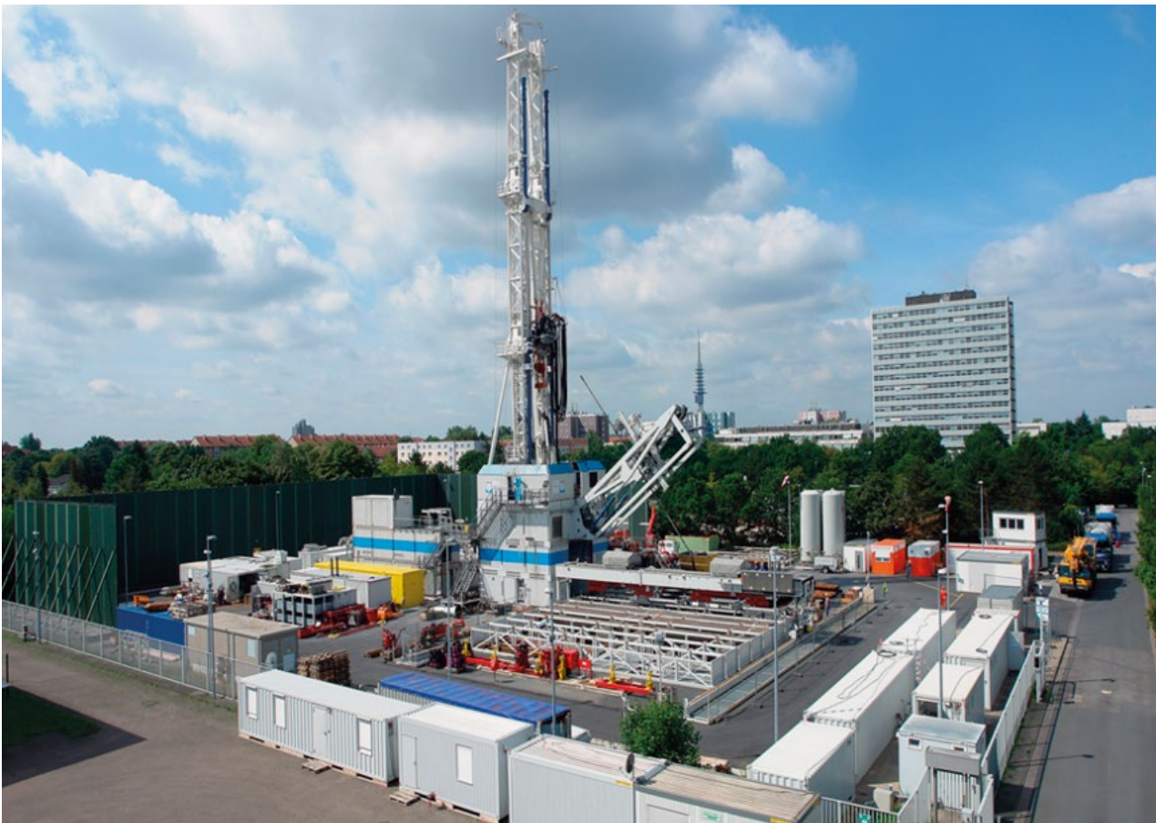
Abbildung 9: Moderne Tiefbohranlage (InnovaRig) in einem urbanen Umfeld in Hannover (Quelle: H. Anger's-Söhne 2009)
