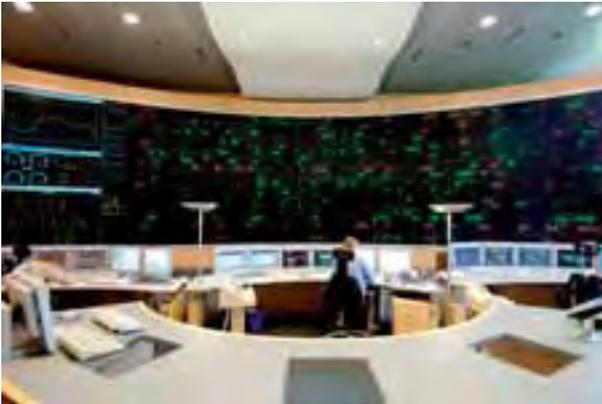
Abb. 2 zeigt die Ansicht einer Netzleitstelle für ein großes Übertragungsnetz. Von hier aus wird das gesamte Transportnetz überwacht, geführt und optimiert.
